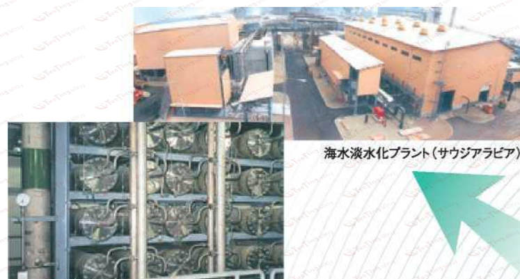
同淡水化プラント内部(RO式海水淡水化装置)
