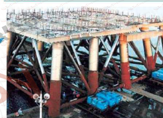
鉄構海洋構造物(ライニング)
