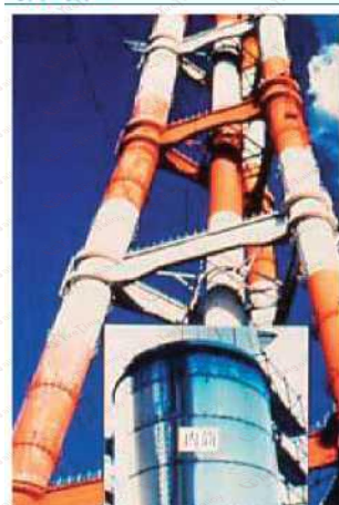
火力発電所煙突内筒
